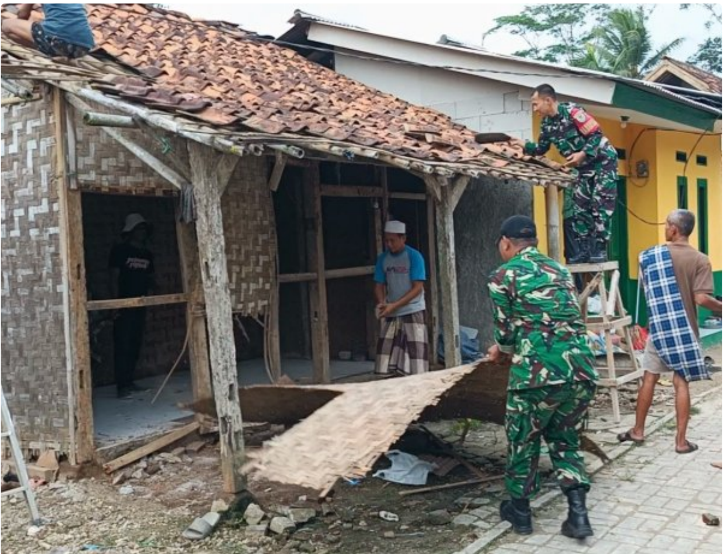
Pembongkaran Rumah Bapak Narmin
