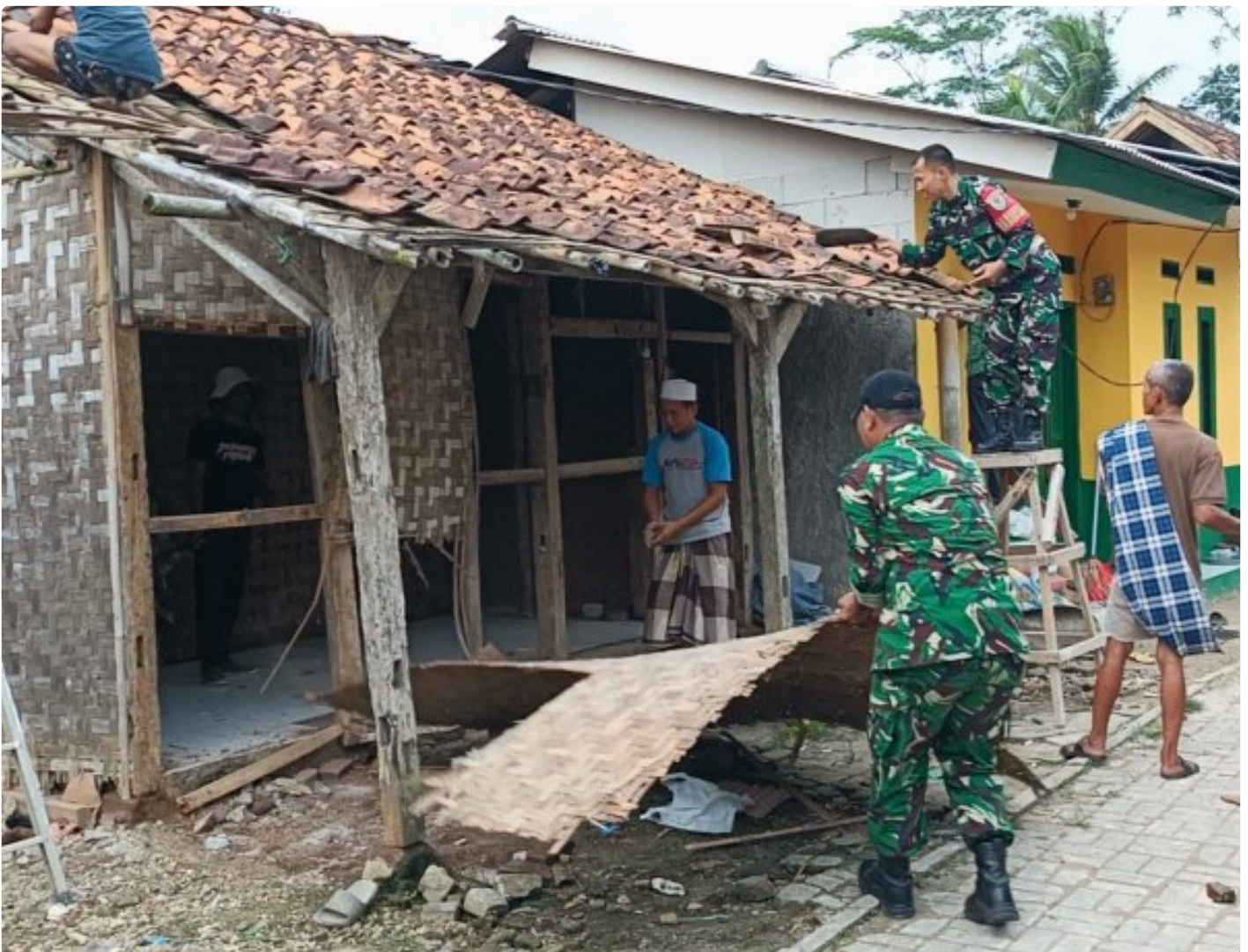
Pembongkaran Rumah Bapak Narmin
